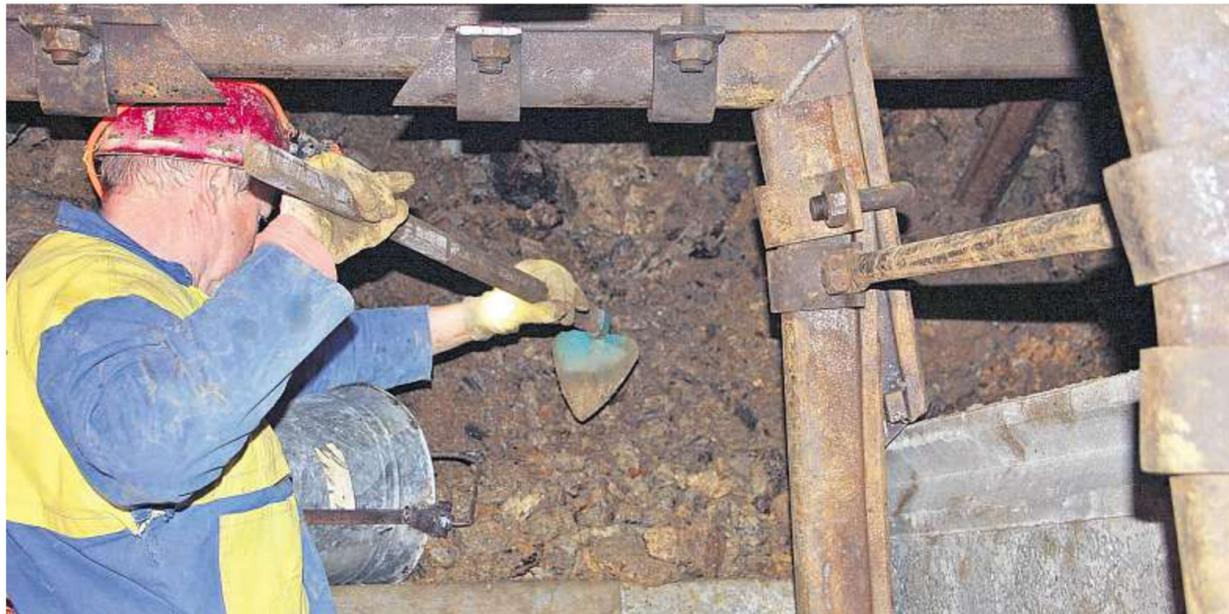
Auch im 21. Jahrhundert arbeiten Bergleute zuweilen ähnlich wie im Mittelalter: Gustav Poncar schiebt mit einer Kratze im Friedrich-Wilhelm-Stollen die Gesteinsschuttmassen in einen Eimer. Der Stollenabschnitt ist massiv mit Stahl ausgebaut und ermöglicht das sichere Arbeiten. *Fotos: Werner Rost*
