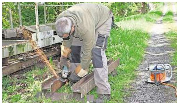
Schwere Stahlträger bereiten die tschechischen Bergleute über Tage für den Einbau im Stollen vor. Jiří Kodera lässt mit einer Flex die Funken sprühen.
