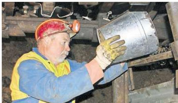
Im nächsten Arbeitsgang schüttet Poncar das Gestein in den Hohlraum hinter dem seitlichen Stahlausbau des Stollens.
